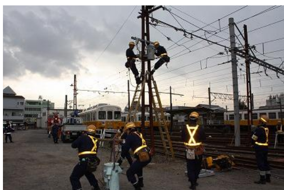
架線復旧訓練
