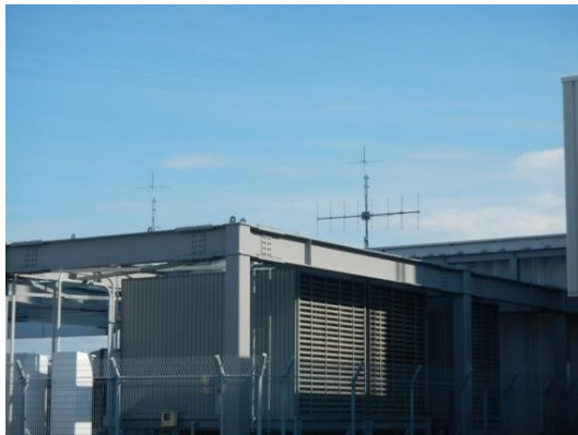
列車無線基地局の更新・移設
