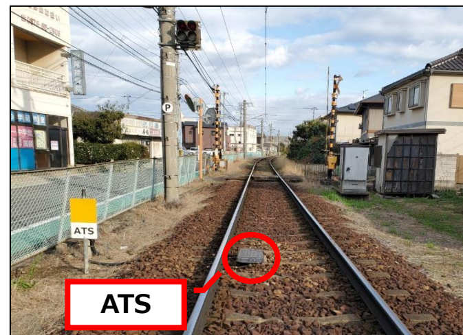
踏切防護用の地上子（絶対停止用）を設置
