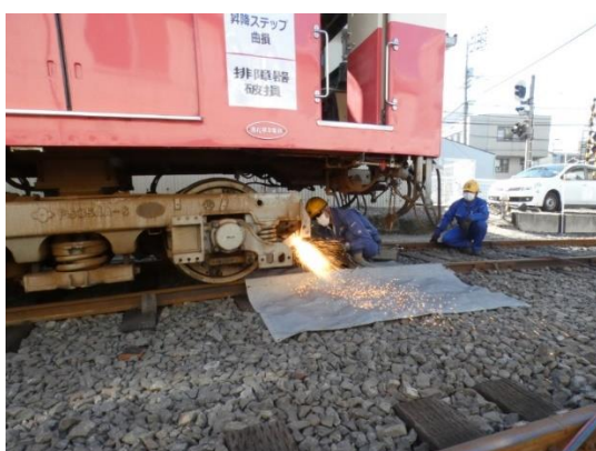
【車両復旧訓練】
