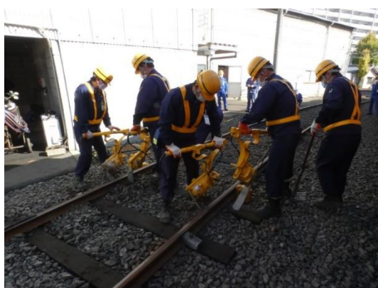
【施設復旧訓練】
