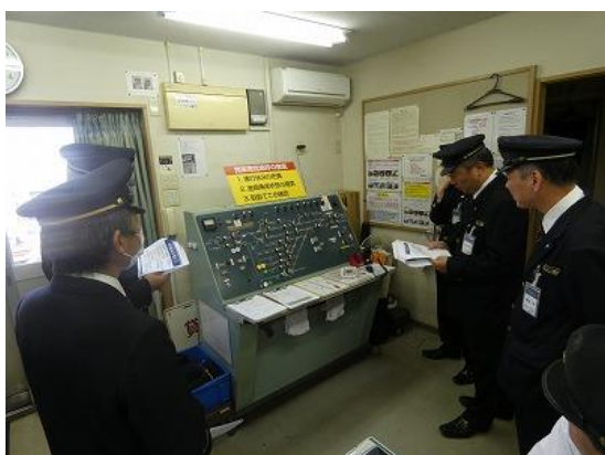
【現場教習(てこ取扱者)】
