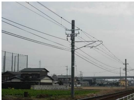
コンクリート柱更新
