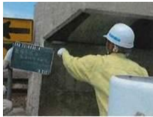
橋梁補修工事
