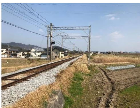
碎石補充状況
