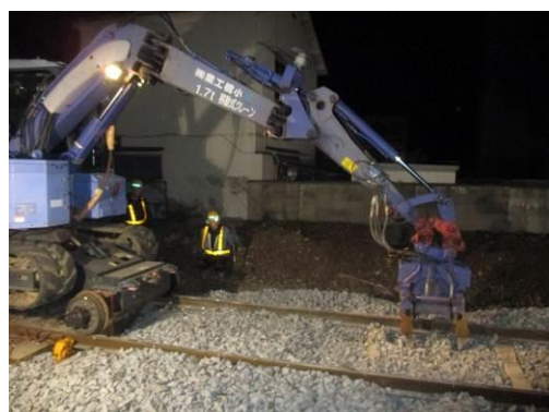
軌道整正工事
