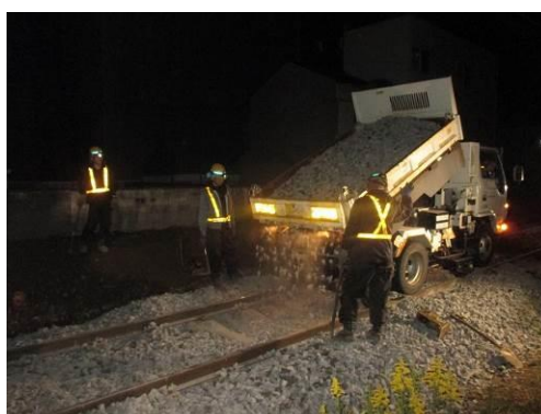
碎石補充工事
