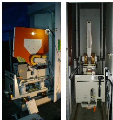
滝宮変電所 直流高速度遮断器
