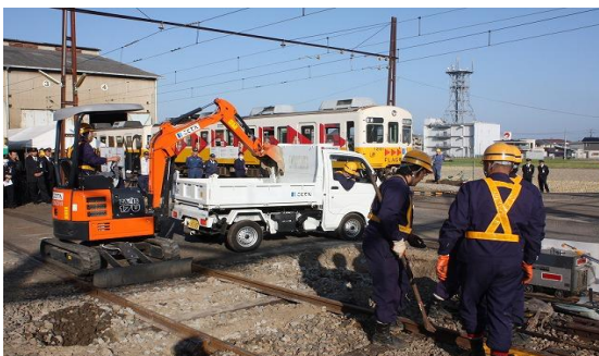
施設復旧訓練
