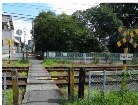
一宮駅構内踏切 改修前
