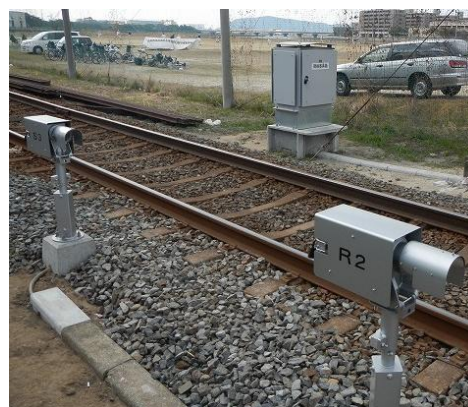
障害物検知装置更新
