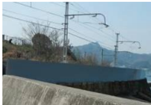
房前防潮堤 改修後
