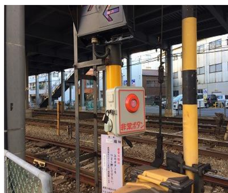
踏切支障報知装置新設
