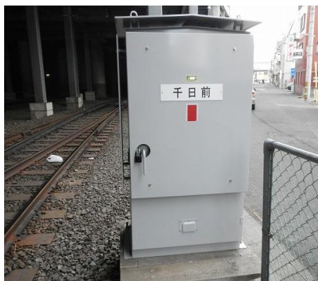
踏切制御装置
