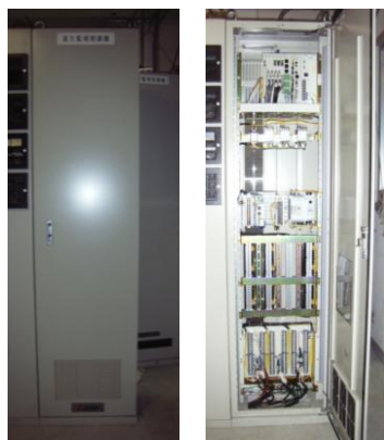
八栗変電所 遠方監視制御装置
