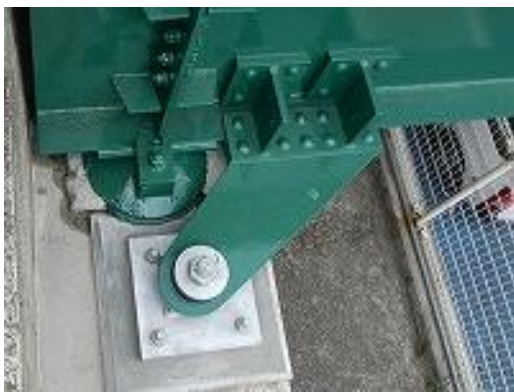
落橋防止工設置
