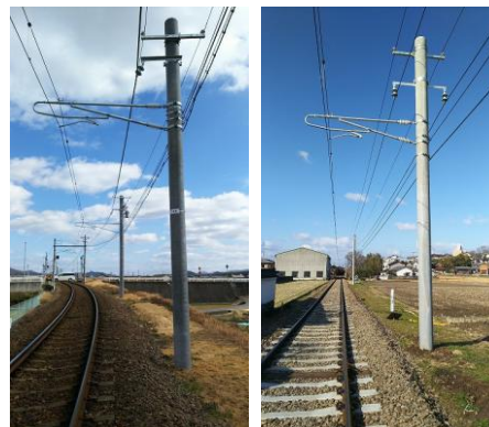
コンクリート柱更新
