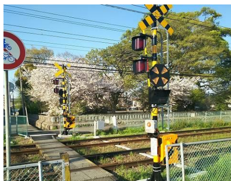
一宮駅構内踏切 改修後
