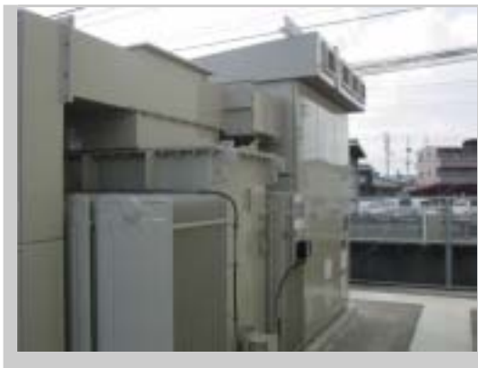
(高田変電所のトランス更新)
