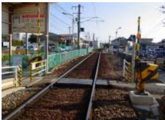
円座駅構内通路の保安装置整備
