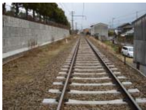
長尾線のPC枕木化
