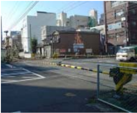
福田町第四踏切の全遮断化 2008/12
