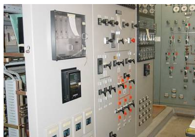
〈変電所改修 2007年度〉
