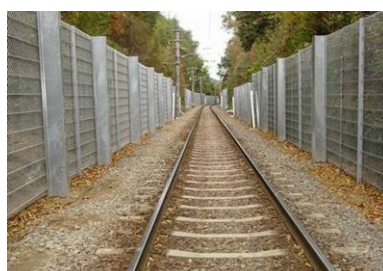
〈落石防止柵の設置 2005年度〉
