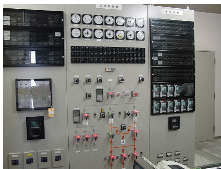
〈瓦町変電所配電盤の改修〉
