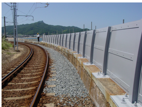
〈房前防潮堤の改修〉
