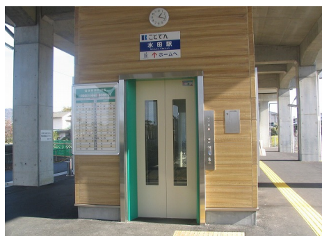
〈水田駅エレベーター車椅子対応〉
