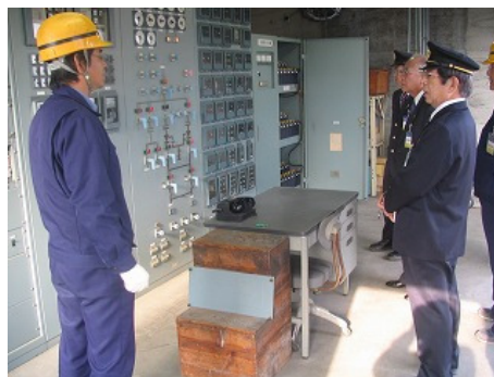
〈滝宮変電所の安全点検 2007/12〉
